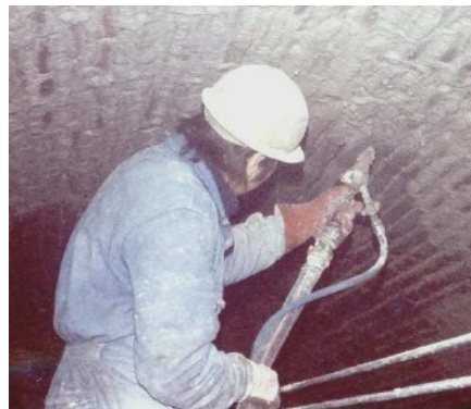
Projection de mortiers ou bétons.
